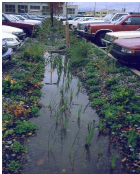
Figura 12. Invasi di piccole dimensioni in aree parcheggio (Figura tratta dal contributo "Come affrontare il rischio idraulico nella pianificazione urbanistica", di A. Paoletti, http://www.csdu.it/CONVEGNI/2011/CREMONA/Cremona%2711_Paoletti-csdu-PoliMI_pres.pdf ).
