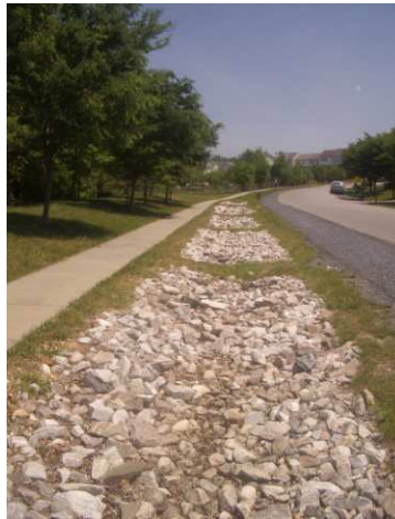
Figura 14. Esempio di canali infiltranti_ http://sustainablestormwater.org
